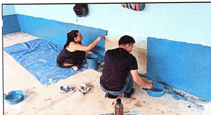
Foto 4: Pintura de muros interior y exterior
