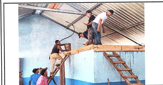
Foto 5: Impermeabilización de losa y reparación del sistema eléctrico
