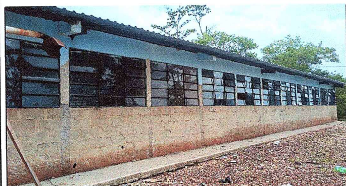
Foto 3: Reparación y cernido de paredes
